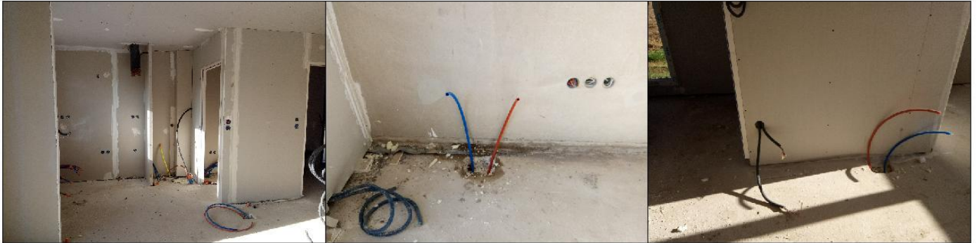
LOGEMENTS DE L'LOT A (+ B03 ET B04) : POSE DES ENJOLIVEURS ET DUPETIT MATERIEL ELECTRIQUE EN FINITION
