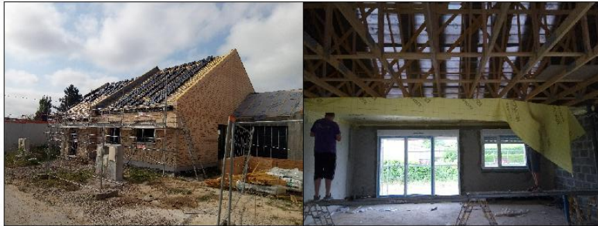
LOGEMENTS A01 ET A02 CHARPENTES TERMINEES - COUVERTURE TUILES EN CHARGE - POSE MEMBRANE EN COURS
