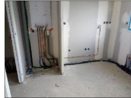
LOGEMENTS A03 ET A04 DISTRIBUTION CUIVRE TERMINEE
