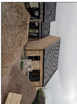
LOT B - LOGEMENTS B03 ET B04 : DEBUT DE POSE DES MENUISERIES EXTERIEURES
