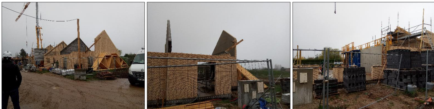
ILOT A - LOGEMENTS A04, A05 ET A06 : POINTES DE PIGNONS TERMINEES - CONTRE-ENDUIT EN COURS SUR A06 - DERNIERES BANCHES COULEES
