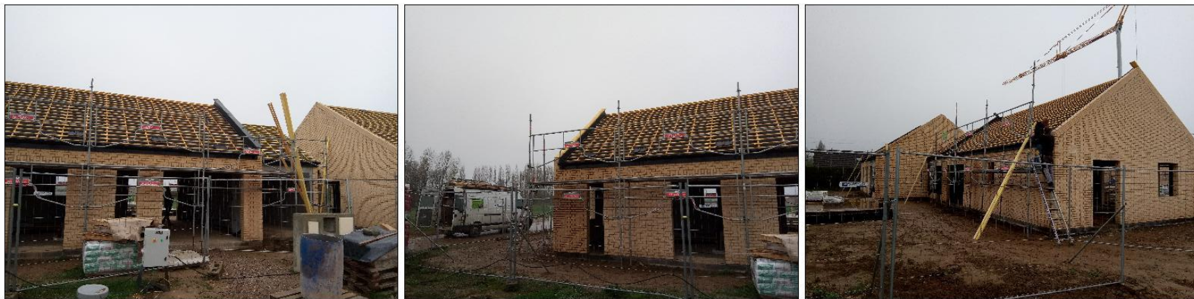
ILOT A - LOGEMENTS A04, A05 ET A06 : POINTES DE PIGNONS TERMINEES - CONTRE-ENDUIT EN COURS SUR A06 - DERNIERES BANCHES COULEES
